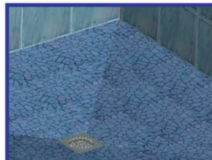
20. Lay the tiles.
